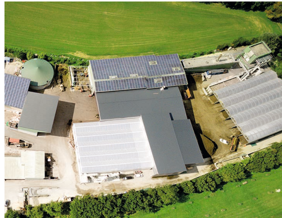
Ecorecyclage, à Lavigny, produit du biogaz grâce aux déchets organiques récoltés auprès de 40% de la population vaudoise.
