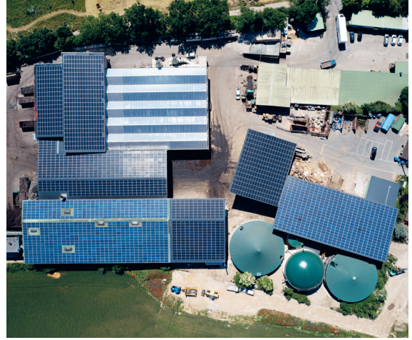
Ecorecyclage, à Lavigny, transforme les déchets organiques de plus de 60 communes vaudoises en biogaz. Ce gaz renouvelable est injecté dans le réseau gazier.
