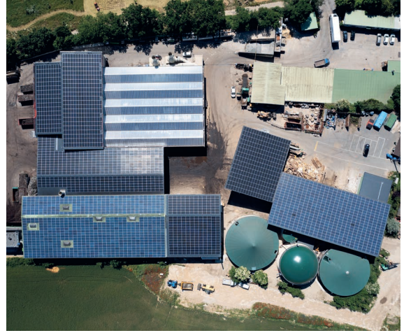
Ecorecyclage, à Lavigny, transforme les déchets organiques de plus de 60 communes vaudoises en biogaz. Ce gaz renouvelable est injecté dans le réseau gazier.
