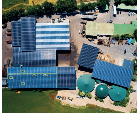
Ecocyclage, à Lavigny, transforme les déchets organiques de plus de 60 communes vaudoises en biogaz. Ce gaz renouvelable est injecté dans le réseau gazier.
