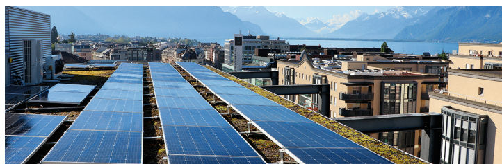
Les panneaux solaires posés sur le toit du bâtiment de Holdinova, à Vevey, produisent 40'000 kWh pour une auto-consommation à 100 %.
